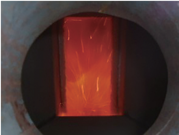
写真1 運転中のCFBボイラ内部の様子
